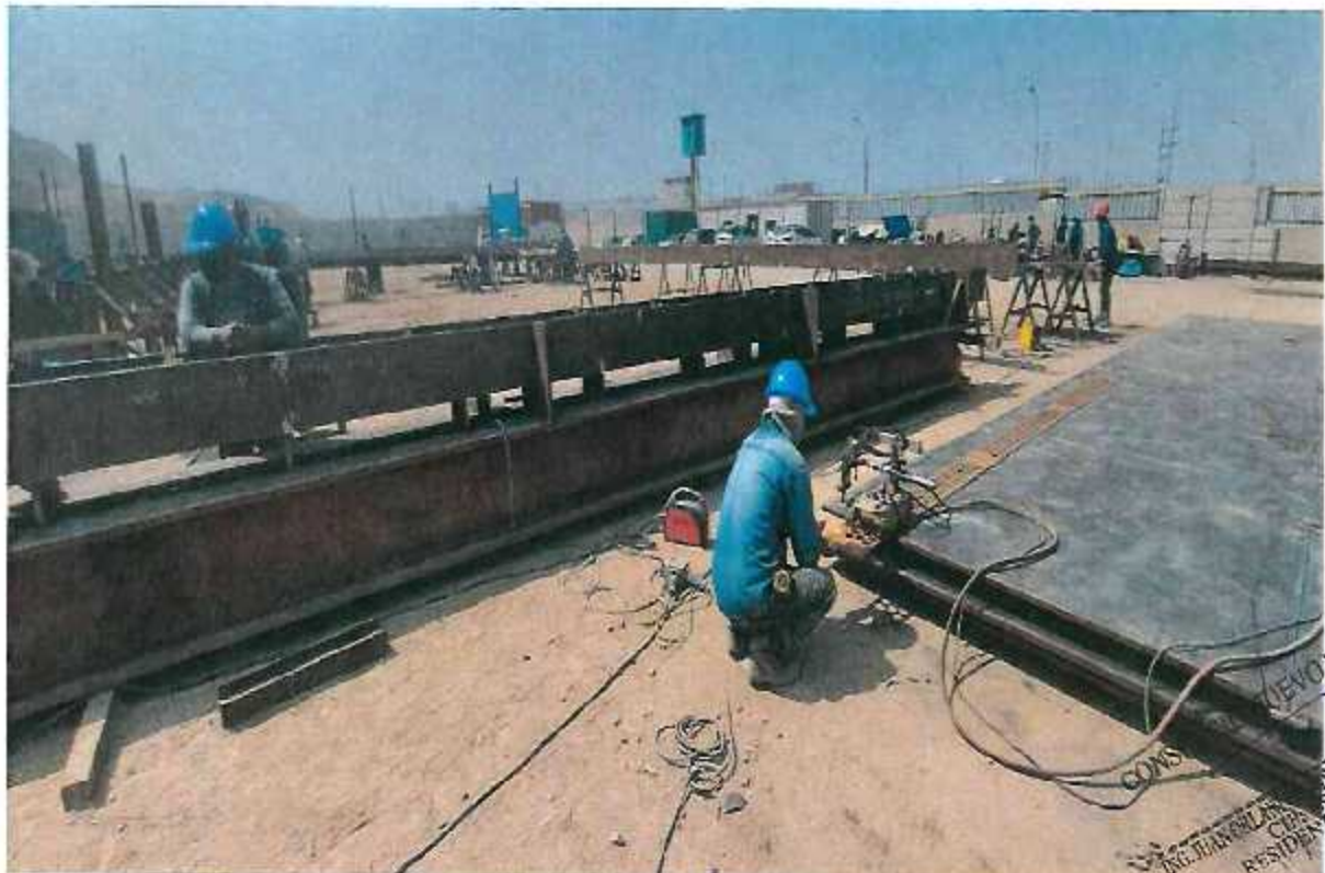
FOTOGRAFÍA N°11: TRABAJOS DE FABRICACION DE ESTRUCTURAS METALICAS
