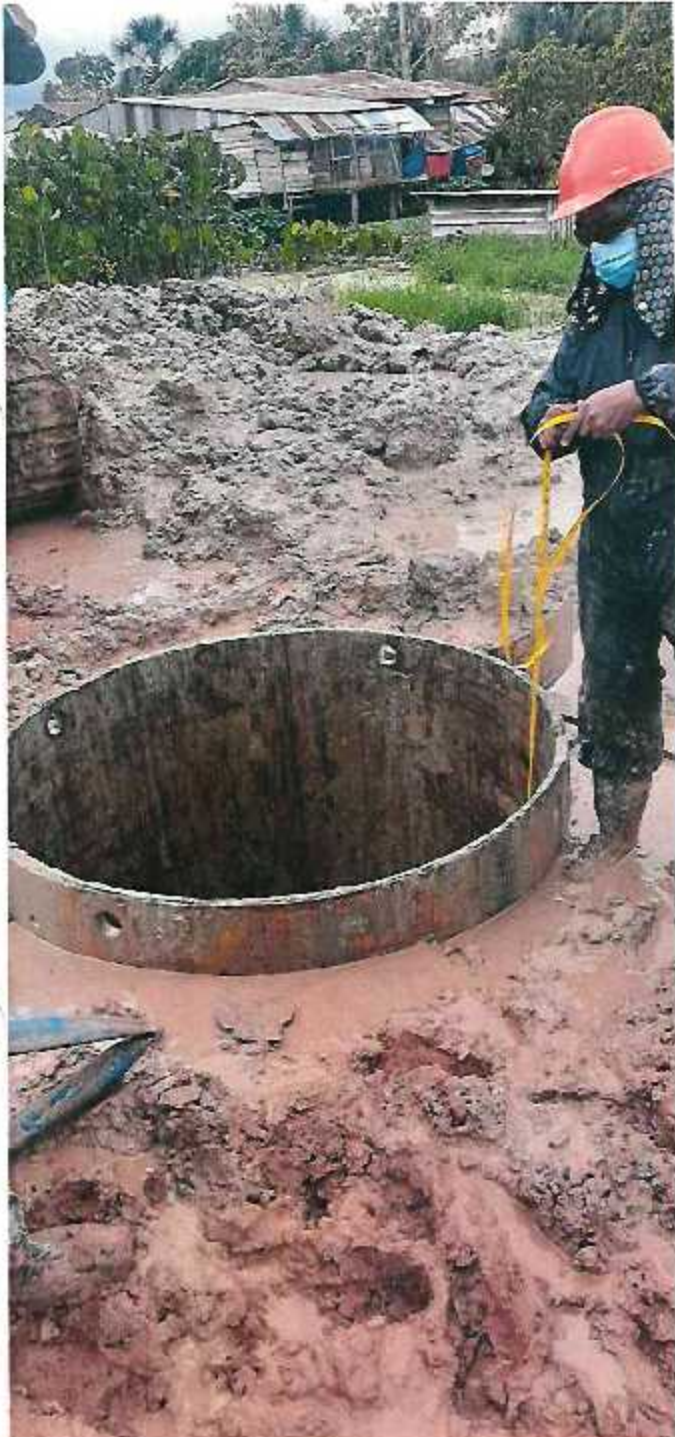
FOTOGRAFÍA N°01: TRABAJOS DE PERFORACION DE PILOTES Y CONTROL DE DIMENSIONES
