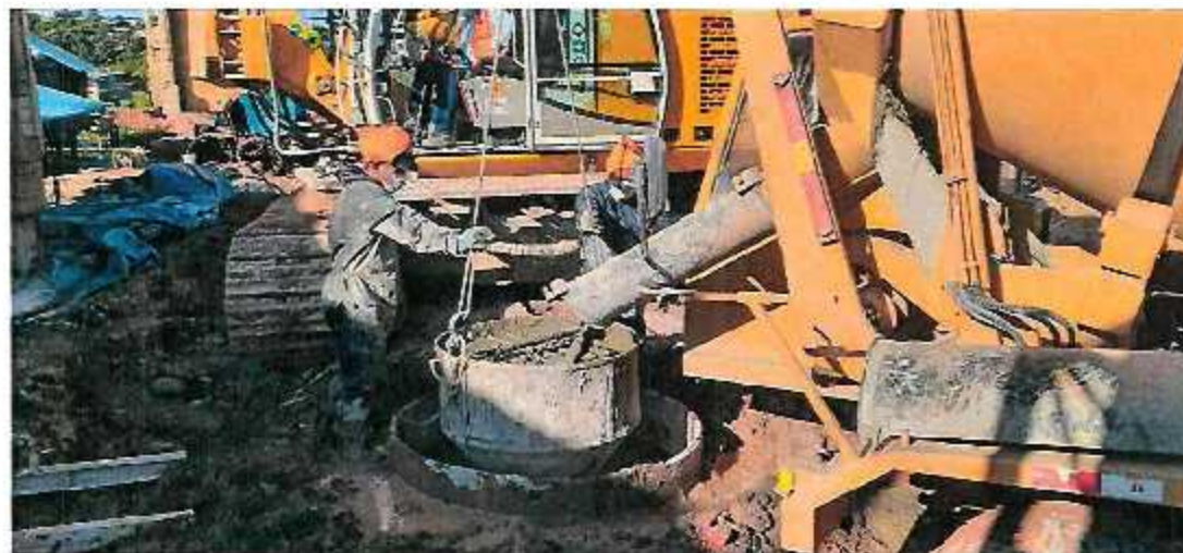
FOTOGRAFÍA N°05: TRABAJOS DE VACIADO DE CONCRETO EN PILOTES DE PROFUNDIDAD DE 8m y 15m.
