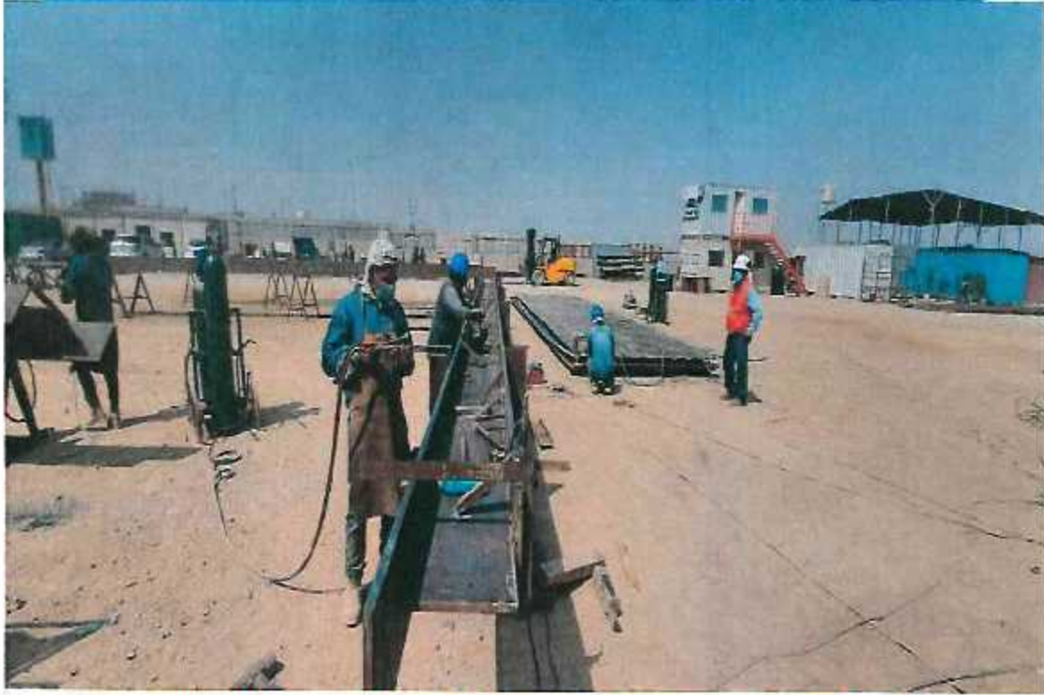
FOTOGRAFÍA N°10: TRABAJOS DE FABRICACION DE ESTRUCTURAS METALICAS
