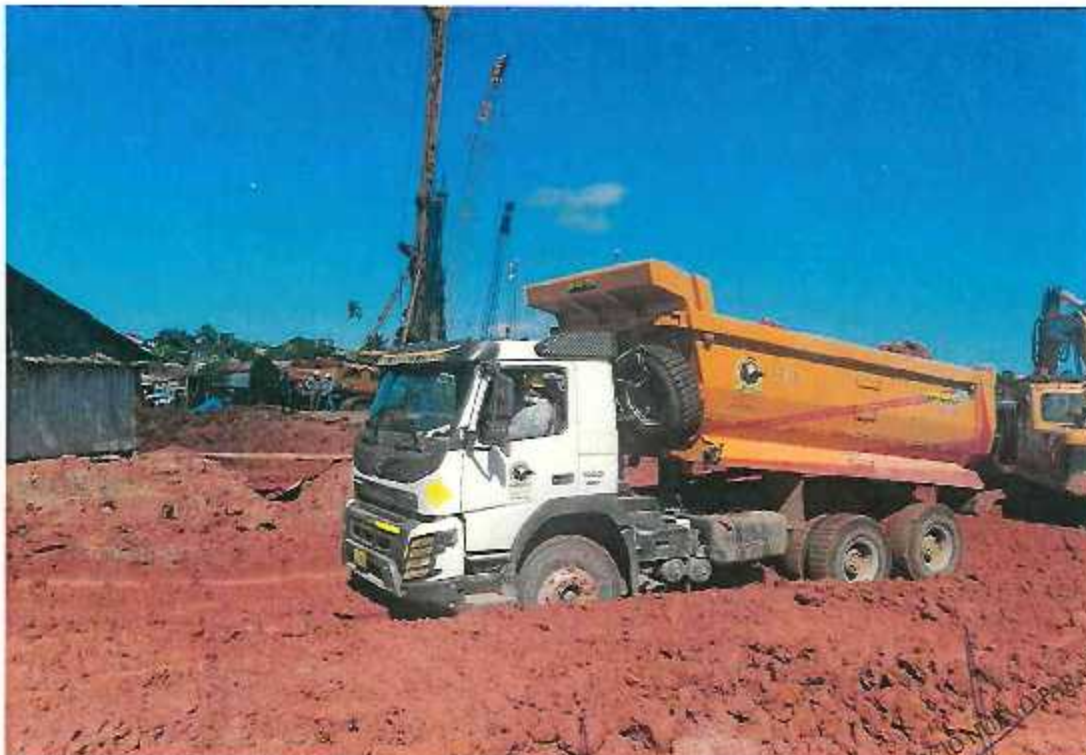
FOTOGRAFÍA N°09: TRABAJOS DE MATERIAL SELECCIONADO ARA CONFORMACION DE PLATAFORMA DE ACCESO
