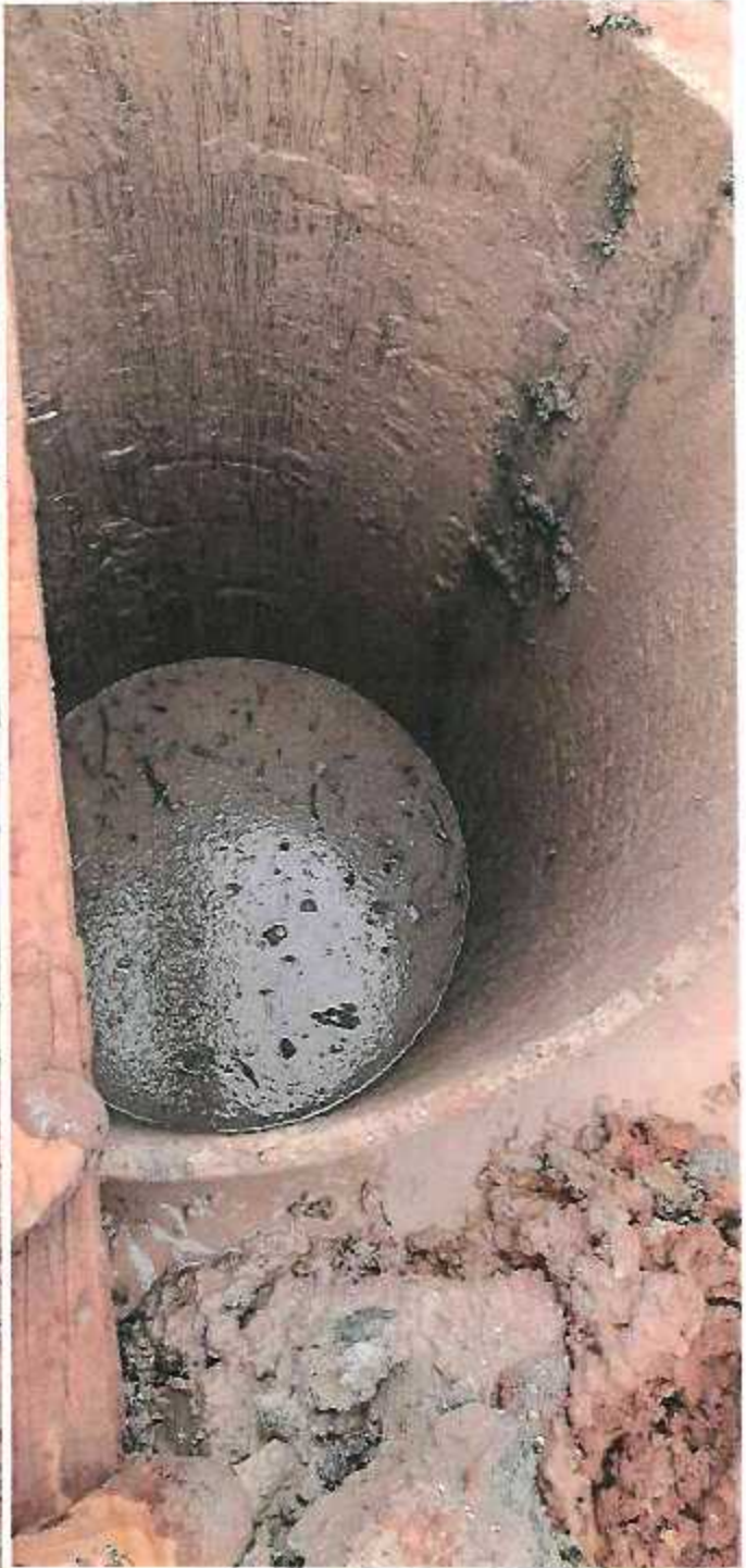
FOTOGRAFÍA N°01: TRABAJOS DE PERFORACION DE PILOTES Y CONTROL DE DIMENSIONES
