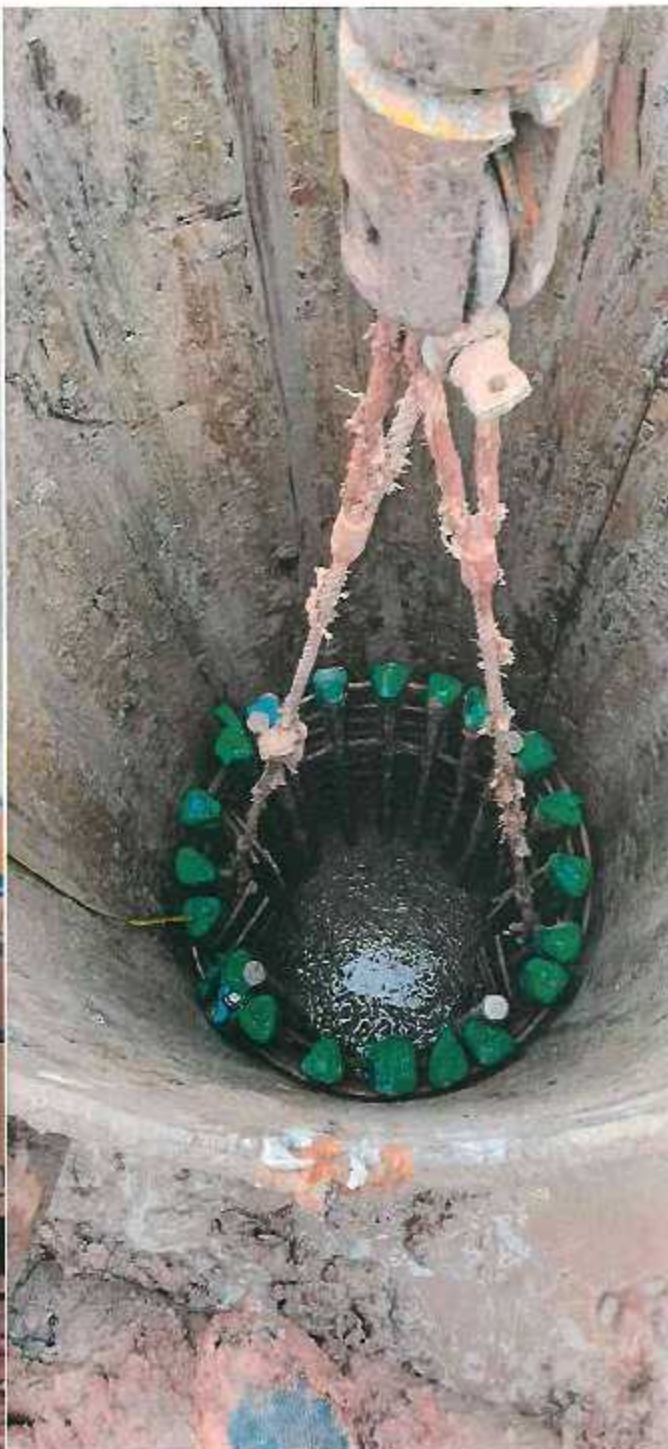
FOTOGRAFÍA N°04: TRABAJOS DE COLOCACION DE ACEROS DE REFUERZO EN PILOTES
