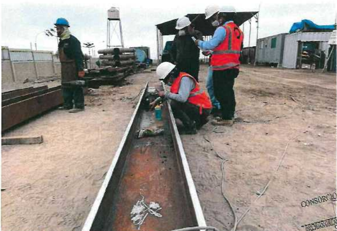
FOTOGRAFIA N°13: TRABAJOS DE FABRICACION DE ESTRUCTURAS METALICAS
