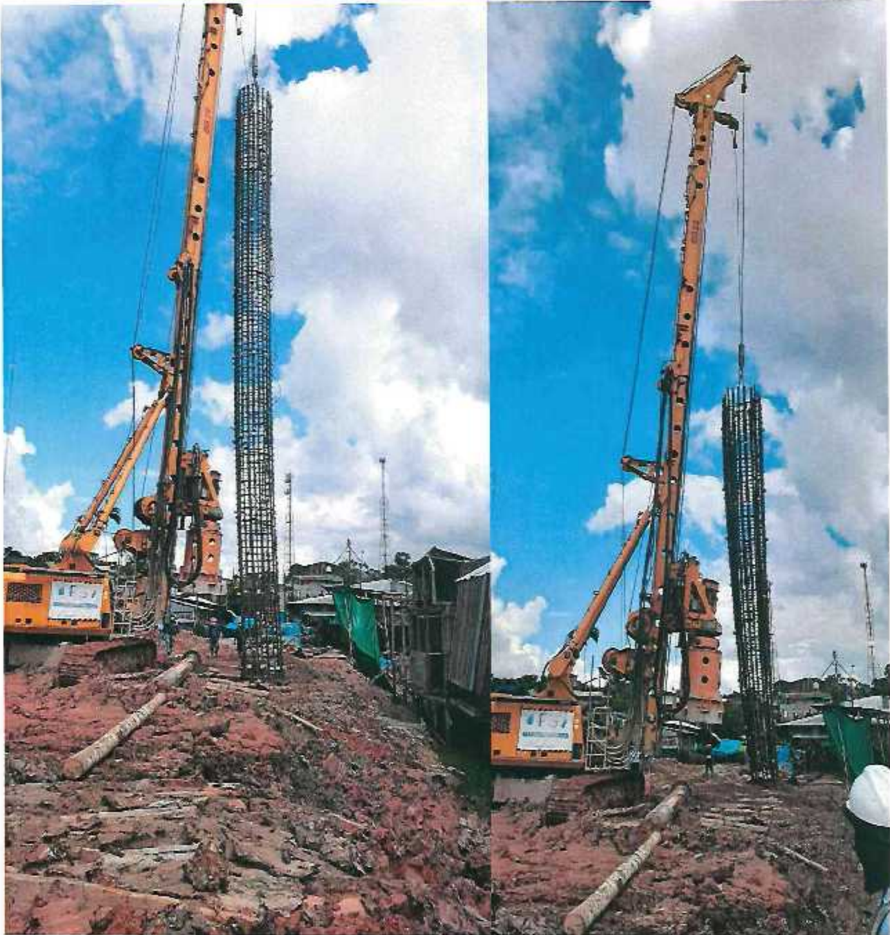
FOTOGRAFÍA N°06: TRABAJOS DE COLOCACION DE REFUERZOS CON AYUDA DE GRUAS
