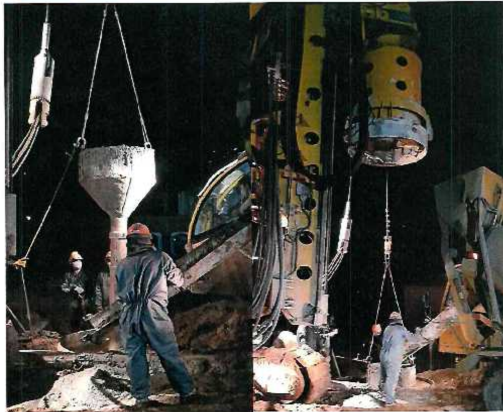
FOTOGRAFÍA N°01: TRABAJOS DE ARMADO DE ACERO Y VASEADO DE CONCRETO EN PILOTES
