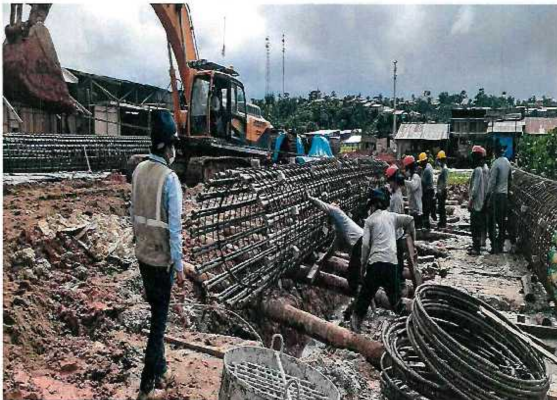
FOTOGRAFÍA N°04: TRABAJOS DE ARMADO DE ACERO EN PILOTES
