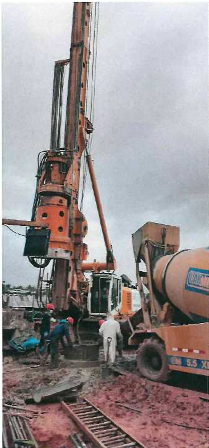
FOTOGRAFÍA N°04: TRABAJOS DE COLOCACION DE ACEROS DE REFUERZO EN PILOTES
