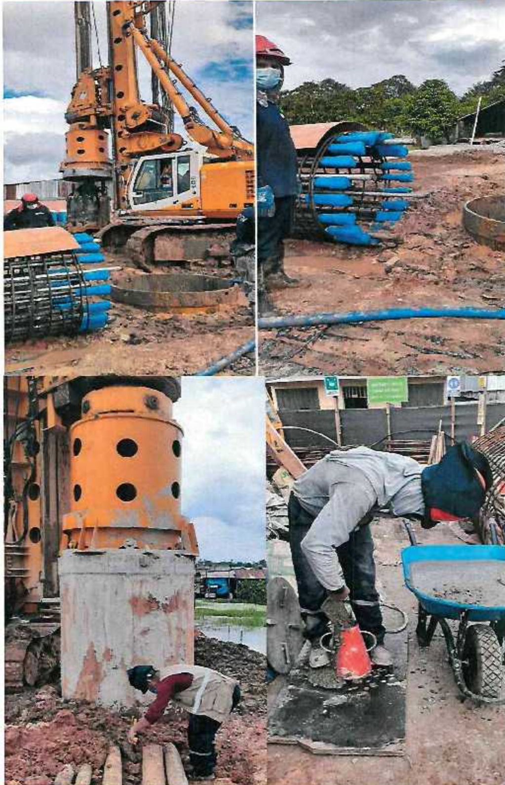
FOTOGRAFIA N°02: TRABAJOS DE ARMADO DE ACERO EN PILOTES - PRUEBA DE CONO DE ABRAMS
