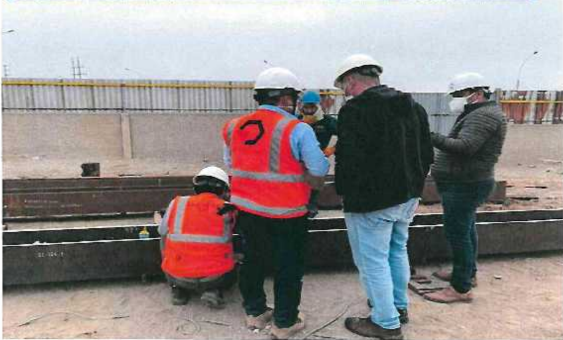
FOTOGRAFIA N°12: TRABAJOS DE FABRICACION DE ESTRUCTURAS METALICAS
